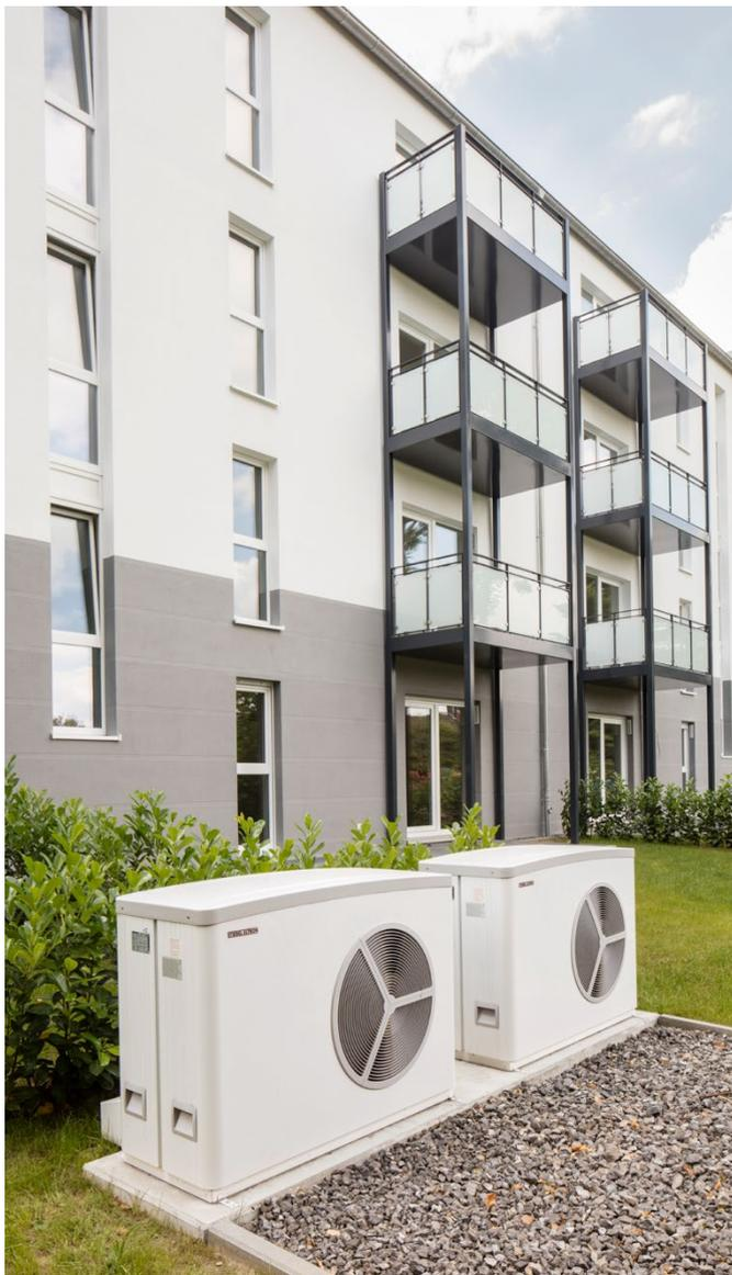
Jedes Gebäude mit neun Wohneinheiten wird von einer Kaskade aus zwei Luft-Wasser-Wärmepumpen WPL 25 A mit Wärme für Heizung und Warmwasserbereitung versorgt.
