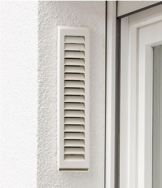
**Die Lüftungsöffnungen für die Pendellüfter wurden in den Fensterlaibungen realisiert und sind damit in der Fassade kaum wahrnehmbar.**
